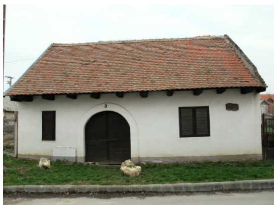
142. kép: Luntz Ottokárné prэшázás lyukpincéje Budaörsön
