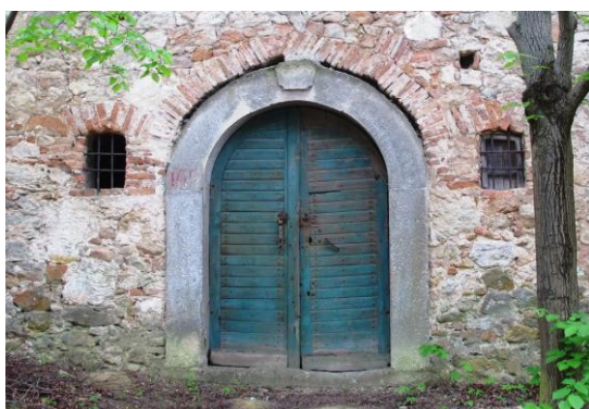
74–75. kép: Téglából kirakott ablak- és ajtókeretek Pátyon
