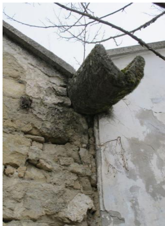
78. kép: Vízelvezető Perbálon a présházak közt
