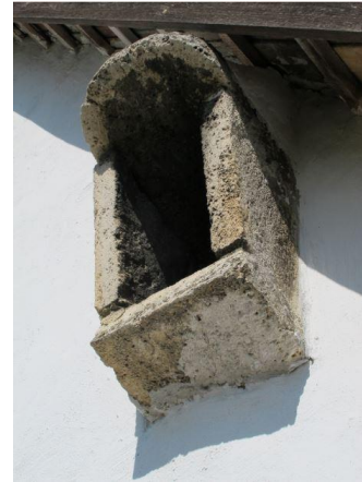
79–80. kép: Töki présházak tűzhelyeinek füstnyílása
