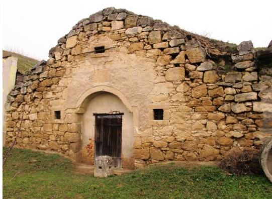
46. kép: Faragatlan kőből készült, egykor vakolt boltozott présház Perbálon
