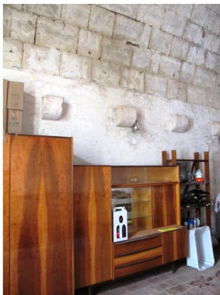
50. kép: Az egykori padlás gerendáit tartó gyámkövek Perbálon
