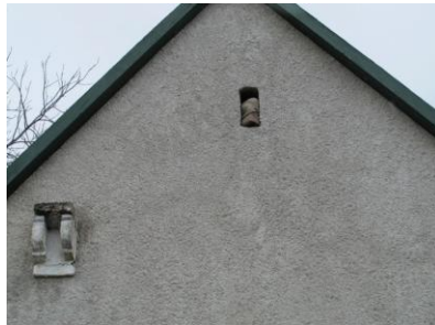
79–80. kép: Töki présházak tűzhelyeinek füstnyílása
