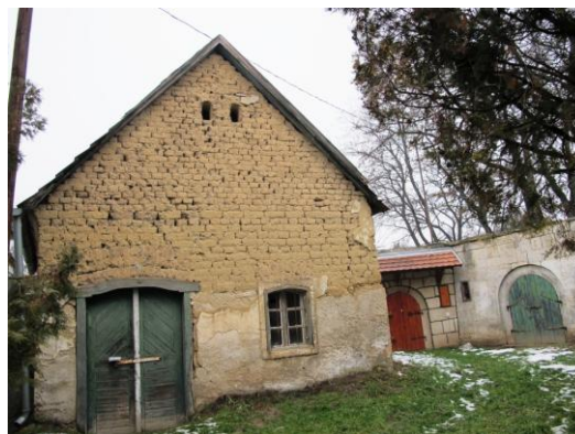
49. kép: Vályogfalú présház Tökön
