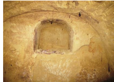
42. kép: Felül íves vakablak egy boltozatlan tőki lyukpincében
