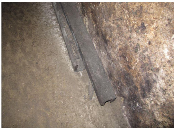
93. kép: Fából készült musteresztő csatorna (Tök)
