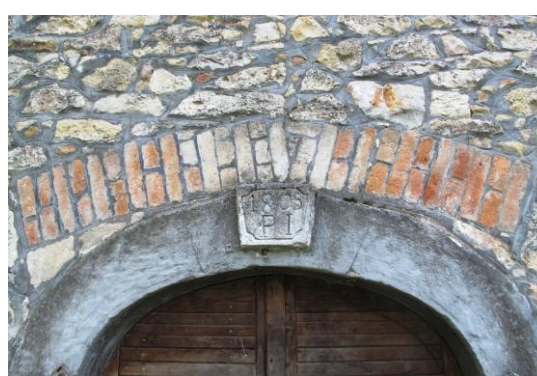
74–75. kép: Téglából kirakott ablak- és ajtókeretek Pátyon
