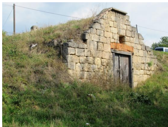
47. kép: Faragott kövekből készült boltozott présház Pátyon
