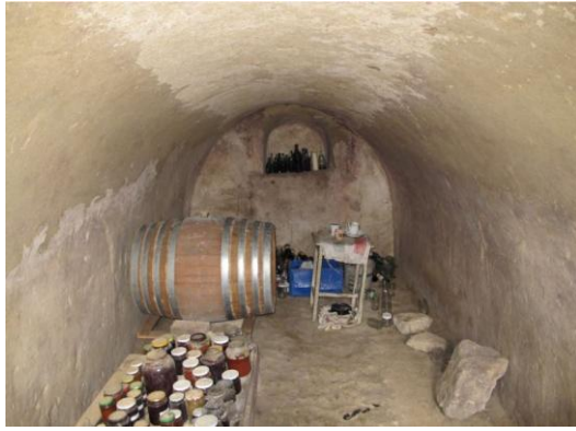
38. kép: Boltozatlan, 1841-ben épült lyukpince Tökön, a Burgundiában
