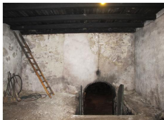
31. kép: Prэшházban kialakított gádor Budaörsön
