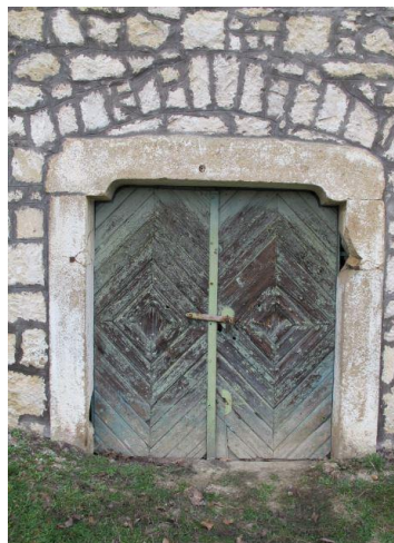
69. kép: Vízszintes áthidalóval rendelkező ajtó faragott kőkerettel körbevéve Perbálon
