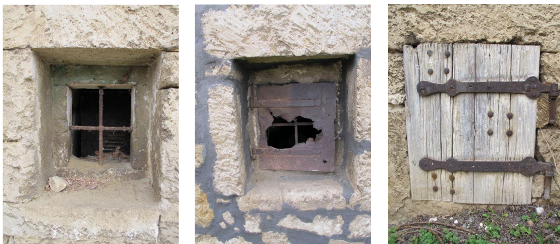
57–59. kép: Boltozott préházás lyukpincék szellőzőablakai Perbálon
