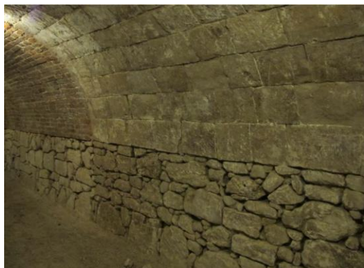
33. kép: Maradék-kőből készült lábazon és szabályos kővel, illetve téglával boltozott pince Perbálon
