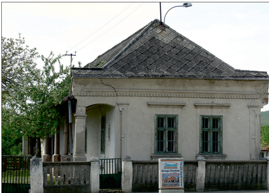
9. kép: A Tájház felújítás előtt. A szerző saját fotója, 2009.
